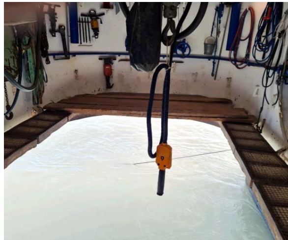
Bild 16-17: Auf der Carl Straat stehen die Arbeiter auf einem Steg am unteren Rand der Glocke und suchen mit langen Stangen im Flussbett nach Hindernissen.
