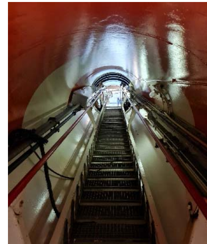
Bild 18: Aufgang vom Druckraum zur Schleusenammer der Carl Straat nach getaner Arbeit.
