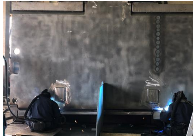
Bild 4: Die Highend-Schweißnähte des 90-Tonnen-Kopfstücks erforderten höchste Kompetenz in Auslegung und Umsetzung.
