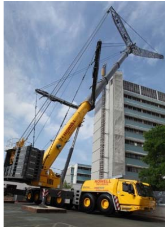
Bild 3-4: In San Antonio, Texas, galt es, bei starkem Wind sieben Tonnen schwere Klimaanlage-Elemente 61 Meter auf das Dach des Methodist Krankenhauses zu heben.
