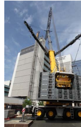
Bild 3-4: In San Antonio, Texas, galt es, bei starkem Wind sieben Tonnen schwere Klimaanlage-Elemente 61 Meter auf das Dach des Methodist Krankenhauses zu heben.
