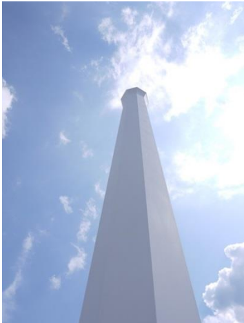
Bild 5: Die fertigen Säulen sind durch ihre Porenfreiheit überaus resistent gegen Salzwasser, Frost und Witterungseinflüsse.
